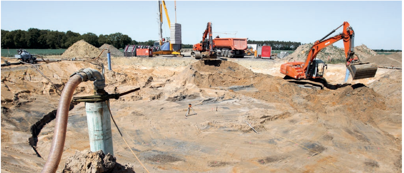
Das für Beedenbostel geplante Repoweringprojekt mit fünf neuen Anlagen vom Typ Siemens SWT 3.0-113 der deanGruppe hat jetzt begonnen.
